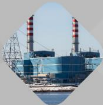
ГАЗОСНАБЖЕНИЕ ВЕРХНЕТАГИЛЬСКОЙ ГРЭС ст.№12 ПГУ 420, г. Верхний Тагил
